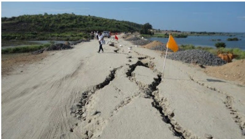
ပုံ (၁) ၁၁-၁၁-၂၀၁၂ သပိတ်ကျင်း ငလျင်လှုပ်သဖြင့် အောက်ခံမြေတွင်း မြေပျော်မှု ဖြစ်ကာ အပေါ်ဖက် တာပေါင်ပျက်စီး သွားပုံ။ (ခါတ်ပုံ - စိုးမင်း ၂၀၁၂)
